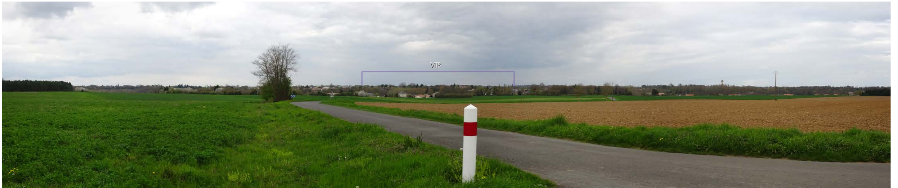
Photo 33 : Depuis la RD36, les vues sont ouvertes sur la silhouette de bourg de Savigné et le VIP qui apparaît avec une prégnance importante
