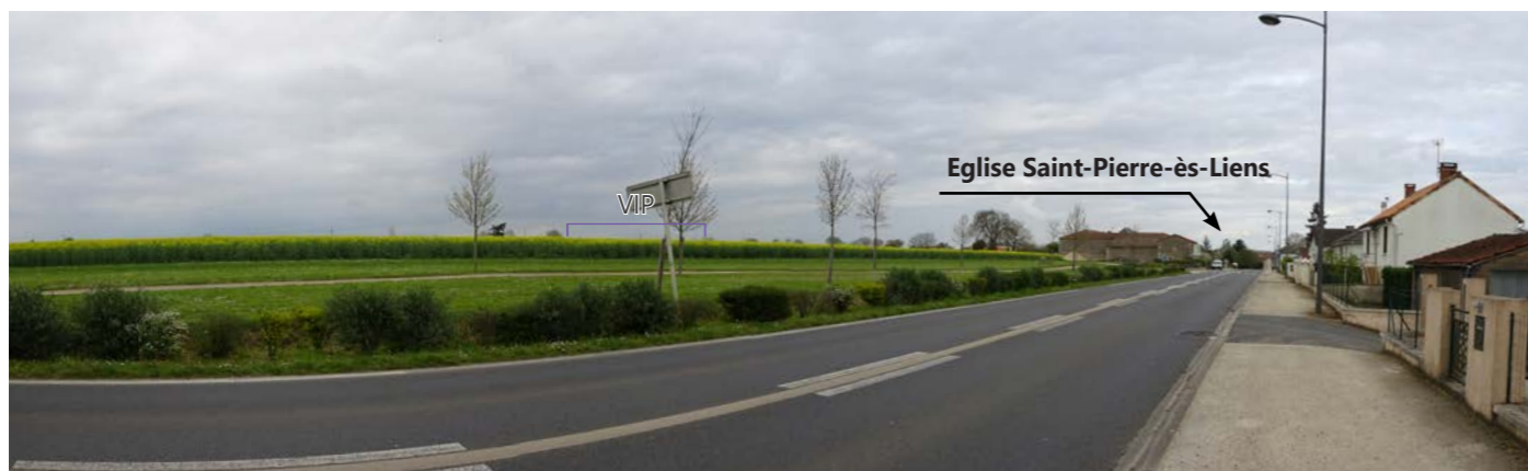
Photo 55 : Depuis la RD 148, le VIP est visible dans le même angle de vue que le clocher de l'église
